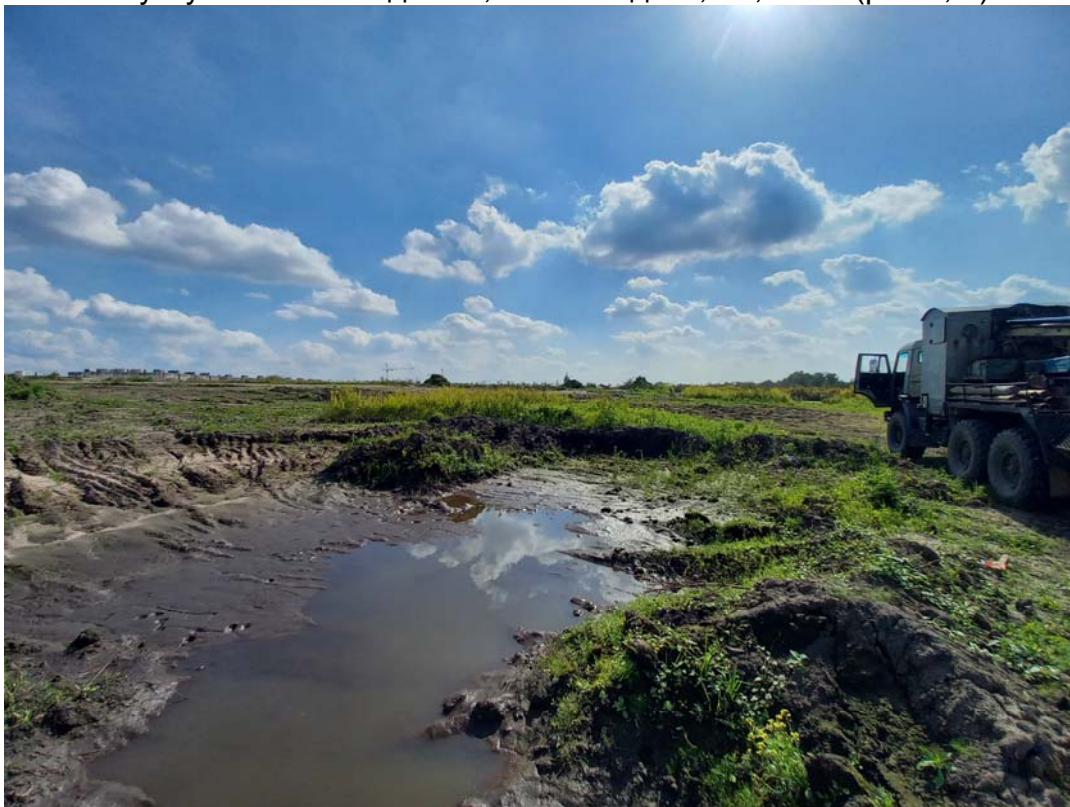
Рис 3. Вид на обводненную выемку грунта в районе скважины и ТСЗ 1306
